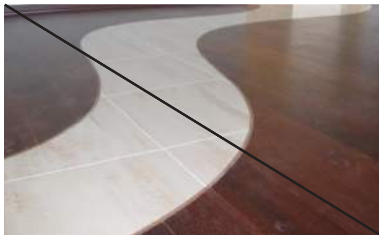
Плохо Узорные стыки из разных материалов
